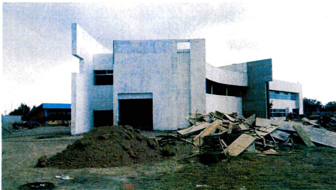
Avance del Edificio tipo S.
